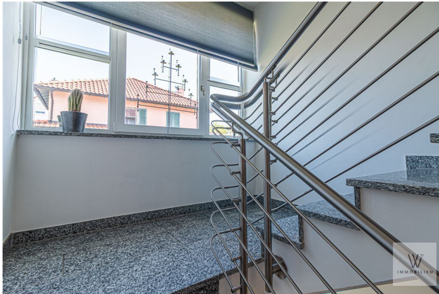
Edelstahlgeländer im Treppenhaus
